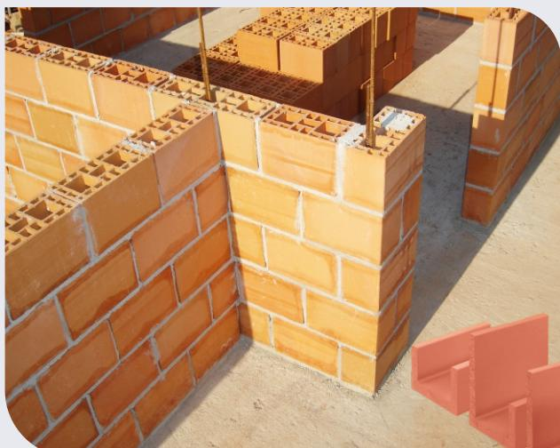
Os blocos cerâmicos estruturais são aplicados em sistemas de alvenaria estrutural onde os próprios blocos desempenham a função da estrutura (viga e pilares) e suportam as cargas da edificação, conforme o projeto do engenheiro responsável. Os blocos estruturais Gresca possuem resistências de 4,0, 6,0 e 8,0 MPa atendendo a NBR15270 e a Portaria Inmetro nº 658/2012. O Grande diferencial desse sistema são os blocos mais resistentes para absorver o peso da obra.
